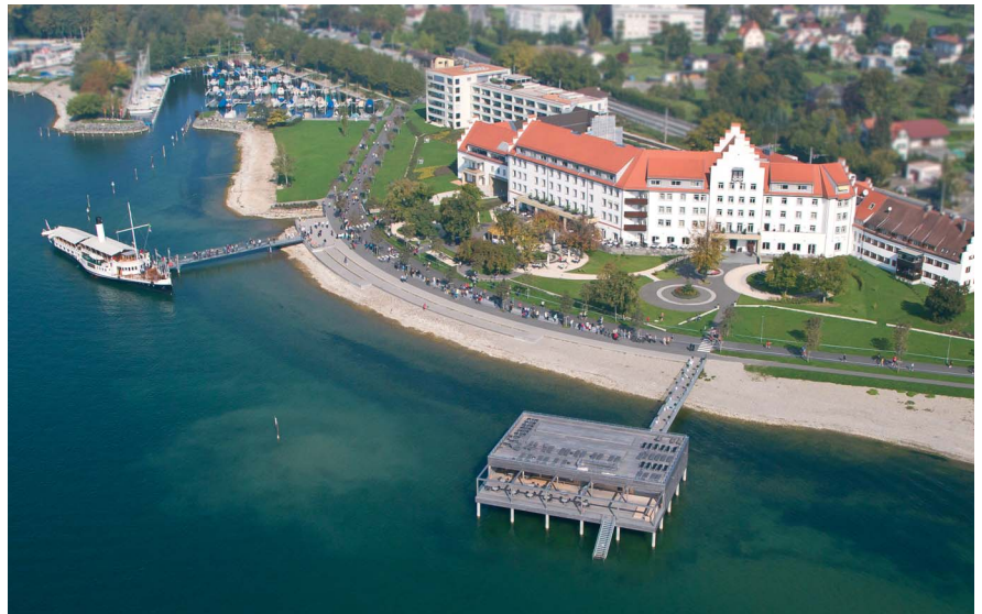
Das Hotel am Kaiserstrand bei Bregenz nutzt Bodenseewasser zur umweltfreundlichen Klimatisierung
