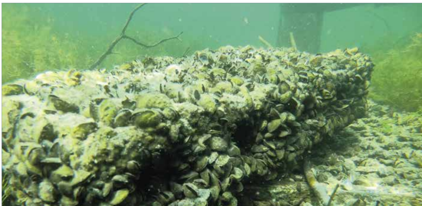
Die Quagga-Muschel hat innerhalb weniger Jahre den ganzen Bodensee besiedelt. Unter anderem setzt sie sich auch auf den Installationen der Trinkwasserversorgung fest. (Bild: Eawag, Linda Haltiner & Christoph Walcher)
