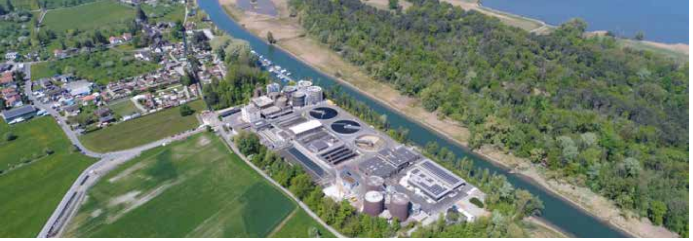
Beim Kampf gegen Spurenstoffe in den Gewässern spielen Kläranlagen eine wichtige Rolle. Die ARA Altenrhein in St. Gallen (im Bild) ist mit einer vierten Reinigungsstufe zur Elimination von Mikroverunreinigungen ausgestattet. (Bild: AVA Altenrhein)
