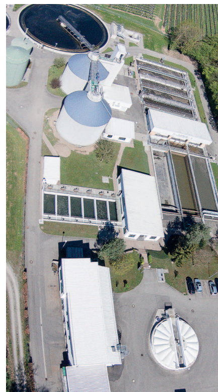
In der Kläranlage Kressbronn werden Spurenstoffe mit Aktivkohle eliminiert. Foto: LRA FN
