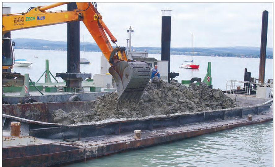
Ausbaggerungen am Bodensee
