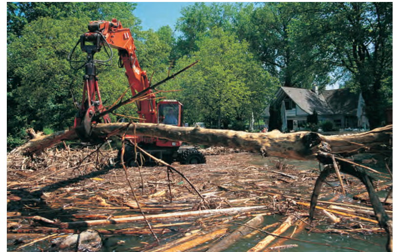
Mitarbeiter der Seemeisterstelle Lindau mit dem Bagger bei der Holzentsorgung.
