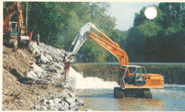
Die Argen-Schwellen «25» (links, während der Bauphase) und «28» (rechts, nach Fertigstellung) wurden mit dem Einbau von Blocksteinrampen restauriert. (Bilder: Sieger)
