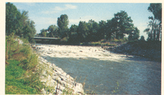
Die Argen-Schwellen «25» (links, während der Bauphase) und «28» (rechts, nach Fertigstellung) wurden mit dem Einbau von Blocksteinrampen restauriert. (Bilder: Sieger)
