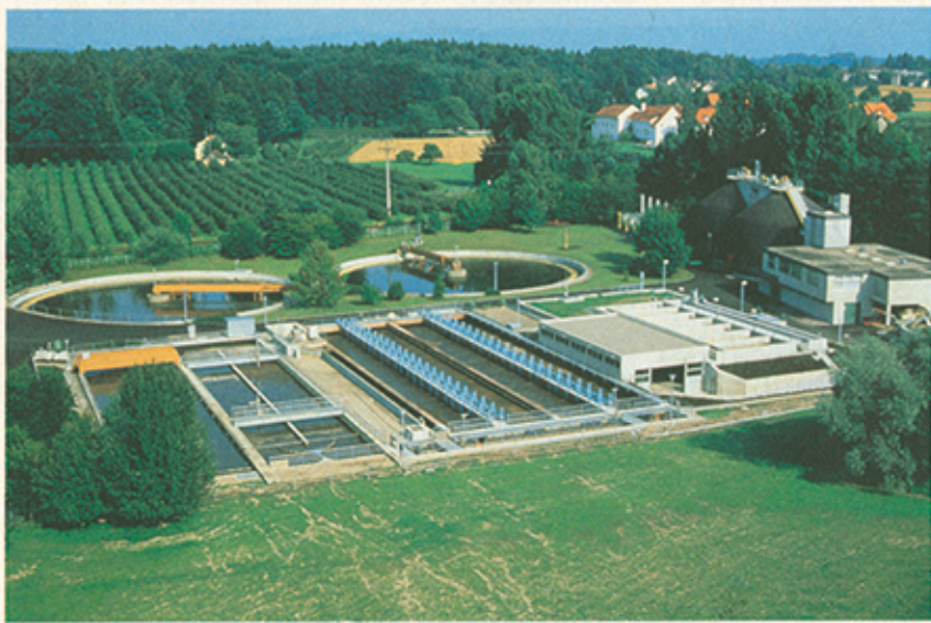
Die Kläranlage des Verbundes unteres Schussental in Eriskirch: bereits mit der Flockungsfiltration bestückt.
